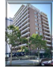
コアマンション ルネス呉服町
